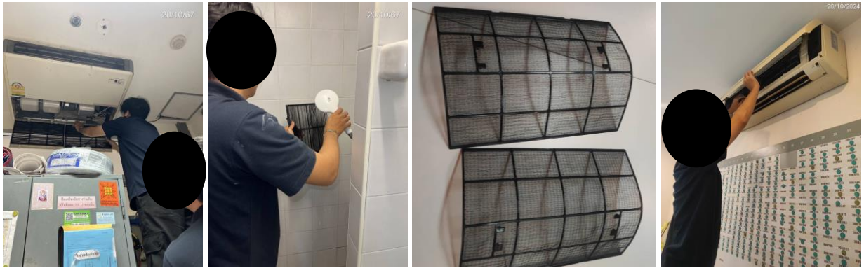
รูปที่ 2-34 ล้างเครื่องปรับอากาศพื้นที่ส่วนกลาง
