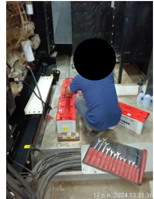
รูปที่ 2-43 งาน PM ระบบเครื่องปั๊มไฟสำรองและเครื่องดับเพลิงประจำปี 2567
