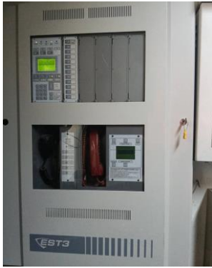
แผงควบคุม (Fire Alarm Control Panel : FCP)
