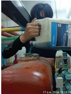
รูปที่ 2-43 งาน PM ระบบเครื่องปั๊มไฟสำรองและเครื่องดับเพลิงประจำปี 2567
